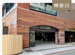
神奈川 工場・社屋：ウッドフェンス： その他
