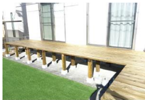
ウッドデッキの施工例
