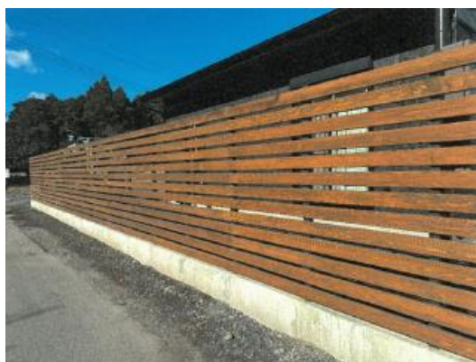
木塀の施工例
